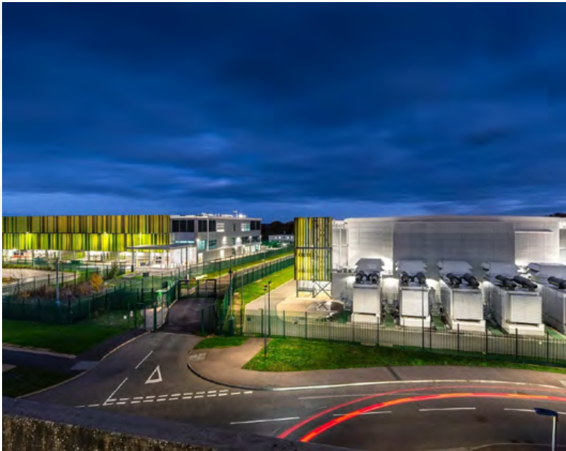
The Kao Data Centre – KLON-02
