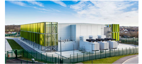
Kao Data campus in Harlow
